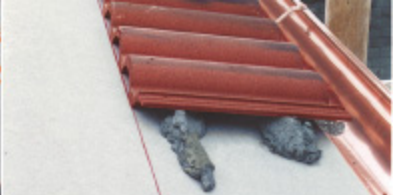
Posare le tegole come di consueto a malta, colla a secco o con listelli e con listelli. Si consiglia il fissaggio di tutte le tegole.
