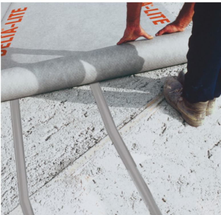
DELTA®-LITE può essere posato in maniera sicura con la colla DELTA®-LITE Pren, senza fiamma.
